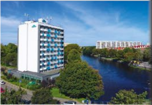
Außenansicht 3+ Aparthotel Nad Parseta
